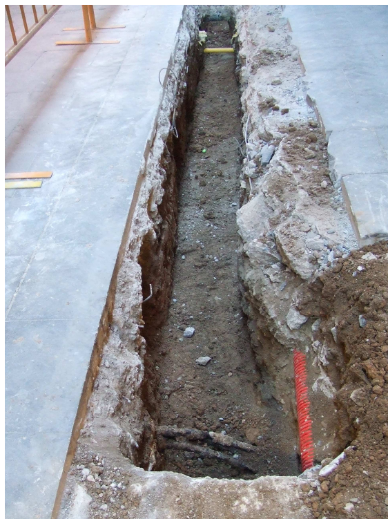
Fotografia núm. 3: Vista de la rasa 1000
