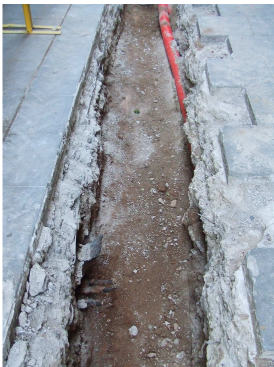
Fotografia núm. 1: Vista de la rasa 1000
