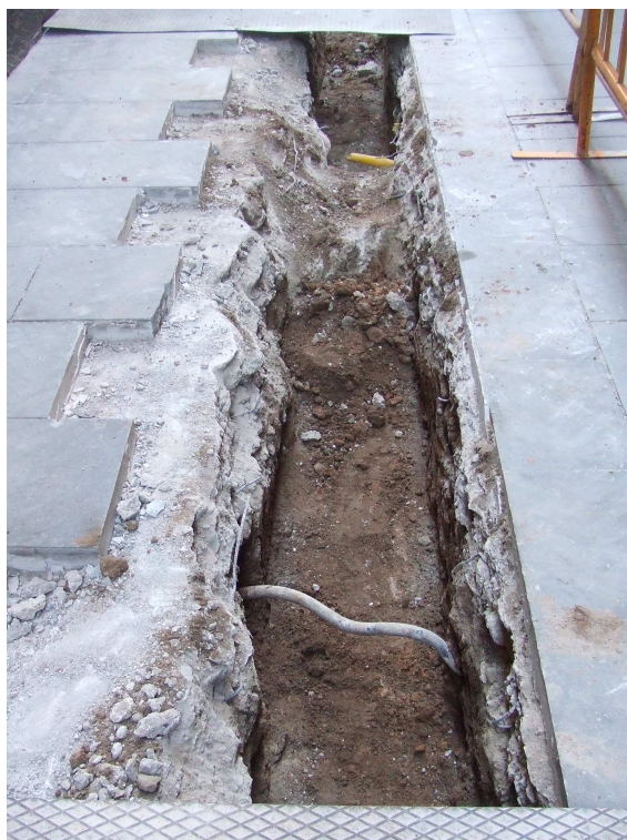
Fotografia núm. 2: Vista de la rasa 1000
